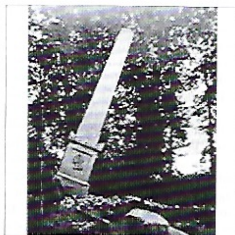
Démolition du monument
